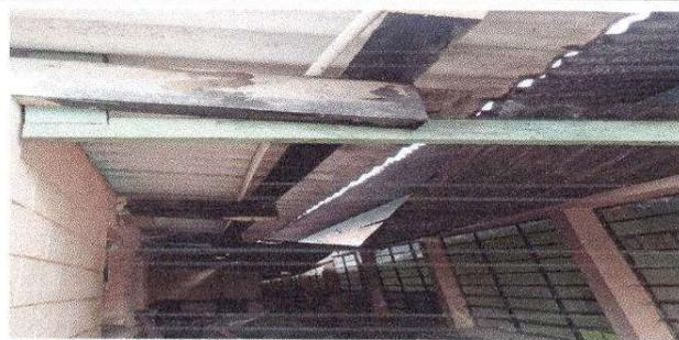
Foto 5: sustitución de canales de metal.
