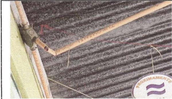
Foto 13: Sustitución de ducto eléctrico y accesorios
