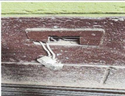
Foto 11: sustitución de tomacorrientes dobles
